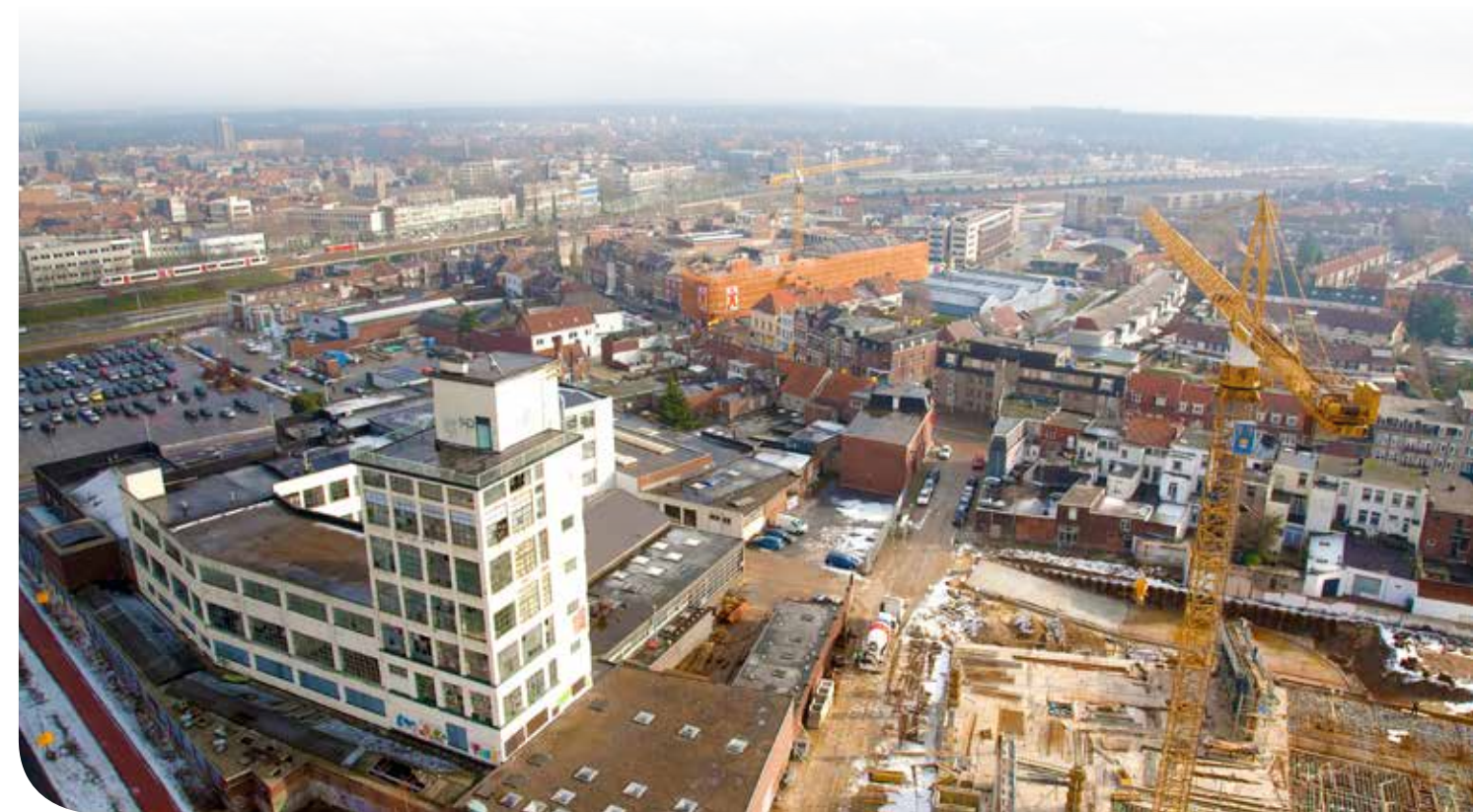
Bouw stadskantoor gevorderd tot storten van vloer begane grond (foto Econsultancy B. Coenders)
