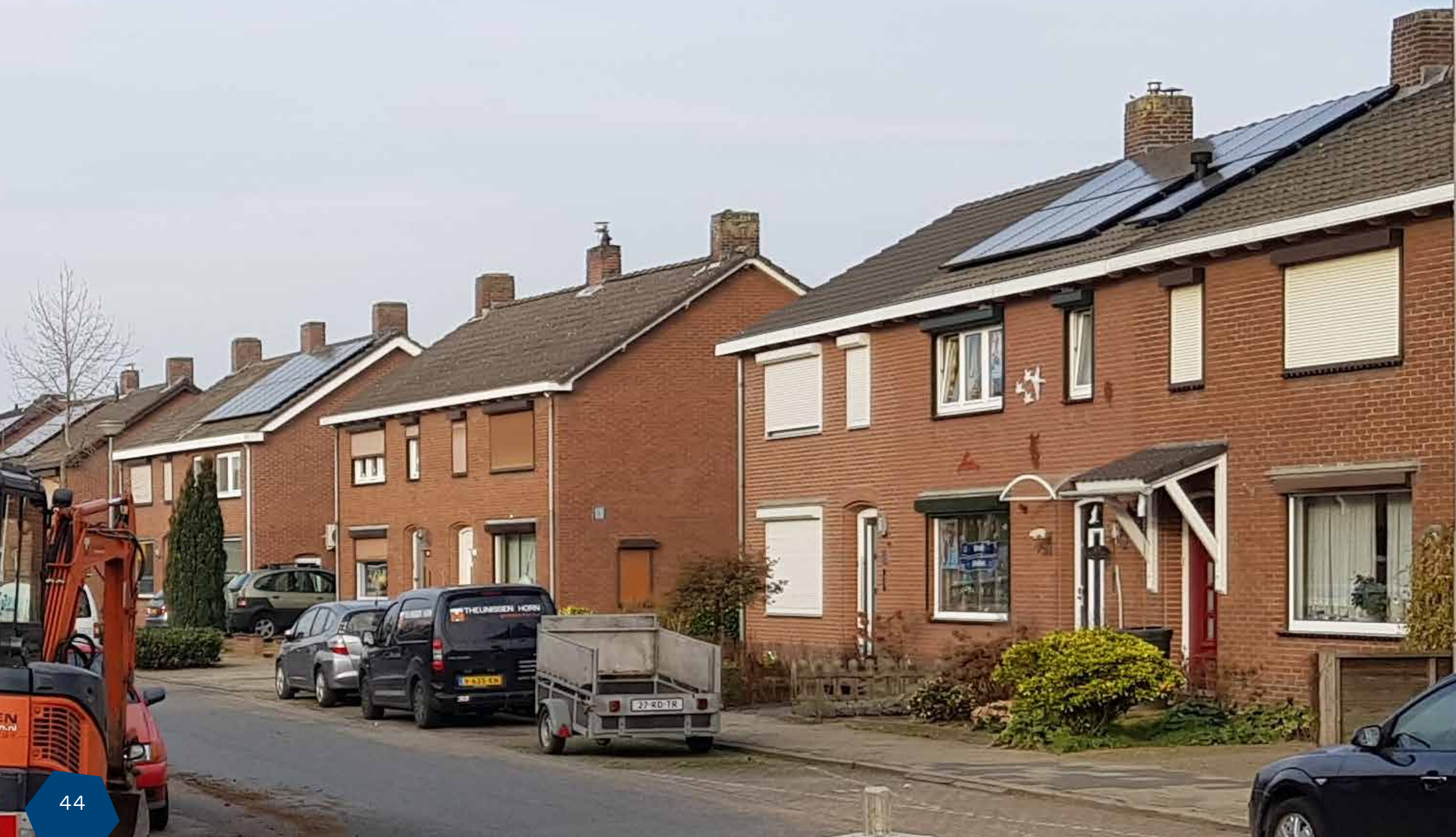
Maasbracht Wilhelminalaan zonnepanelen op dak
