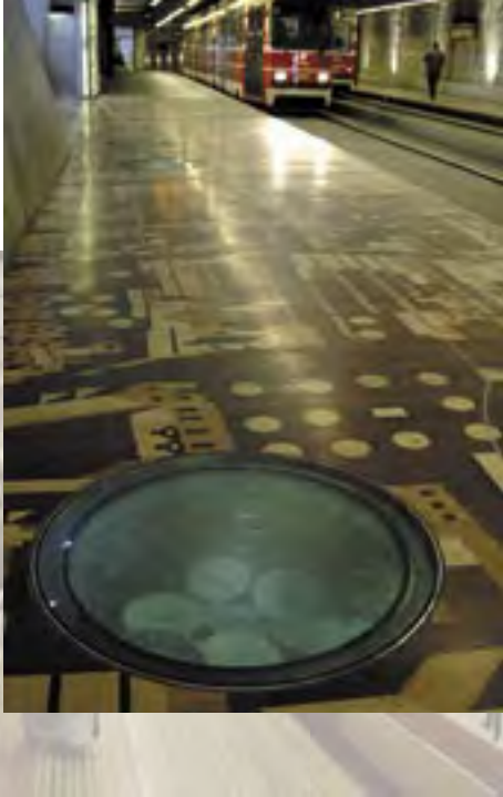
'Met de Haagse tramtunnel is een klein stukje ondergrondse wereld ontstaan. Een fascinerende wereld die ondergronds aansluit op gebouwen en parkeergarages.' Haagse tramtunnel, halte Grote Markt.
